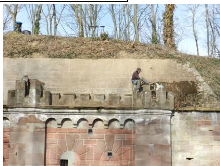
Nettoyage des couronnes
