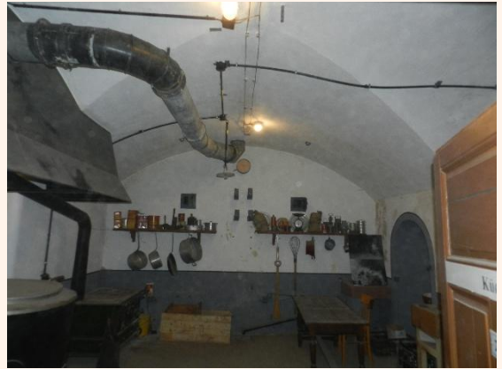
Cuisine du fort Ducrot avec les tubes de ventilations
